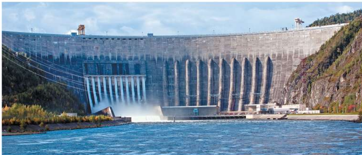
Рис. 37. Плотина Саяно-Шушенской ГЭС
