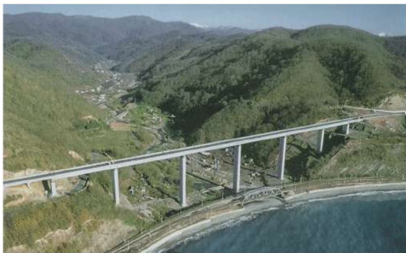
Рис. 92. Мост через ущелье реки Чемитоквадже
