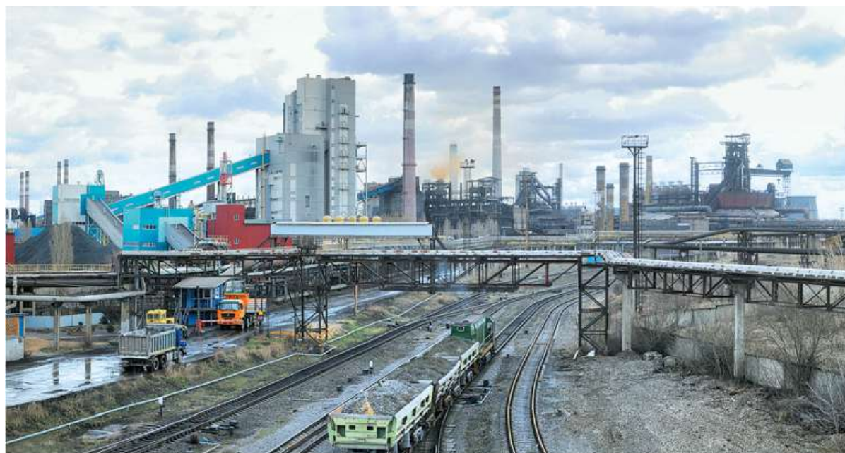
Рис. 80. Новолипецкий металлургический комбинат
